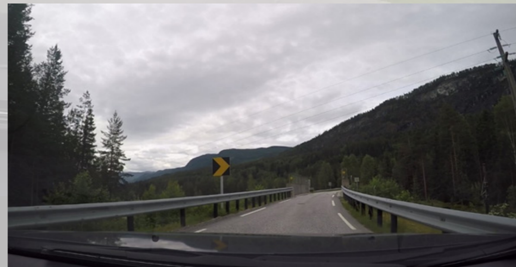
Smal bru, maks bredde 3,6 meter, med bratt stigning inn til bro. Kan medføre trafikale problemer, spesielt for vogntog på vinterstid.
