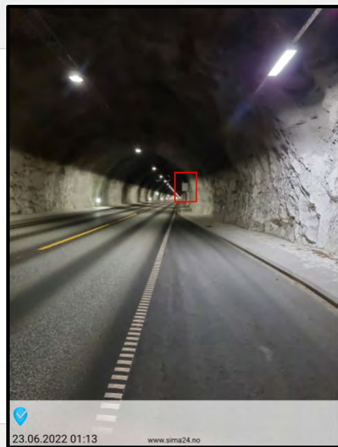
Figur 1 Viser radioskilt og gulblink ved nødstasjon BS18
