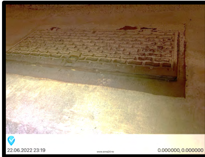
Figur 4 Viser delvis opent lokk på trekkekum.
