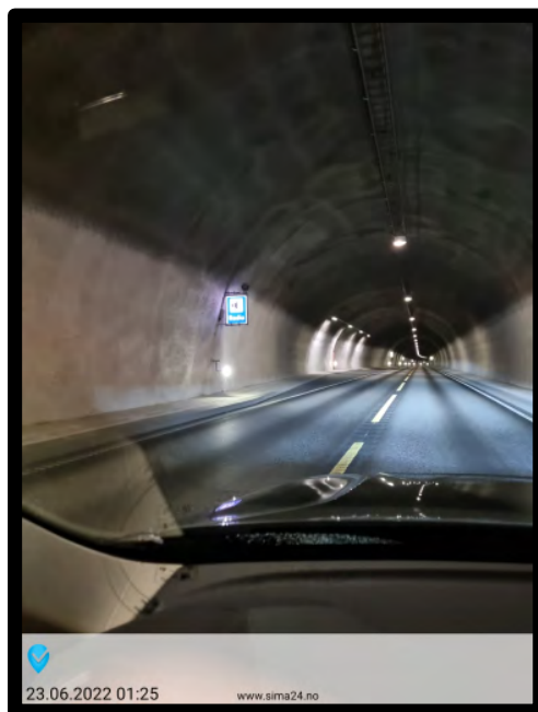
Figur 2 Viser radioskilt og gulblink ved nødstasjon BS30
