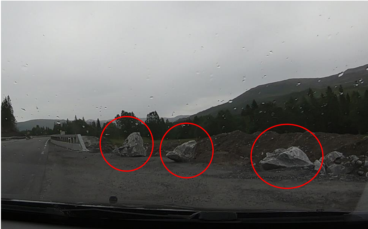
Påkjøringsfarlige element i sikkerhetssonen, steiner brukt som sikring (E6 Helgeland)
