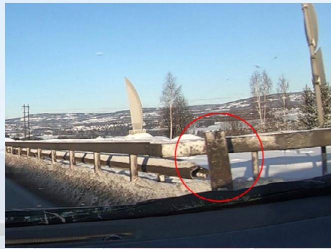
Trafikksikker rekkverks-ende bak midlertidig sikring (70 km/t, mot fartsretning)
