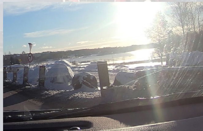
Store steiner er benyttet som sikring av driftsåpning. Disse er påkjørselsfarlige elementer i sikkerhetssonen
