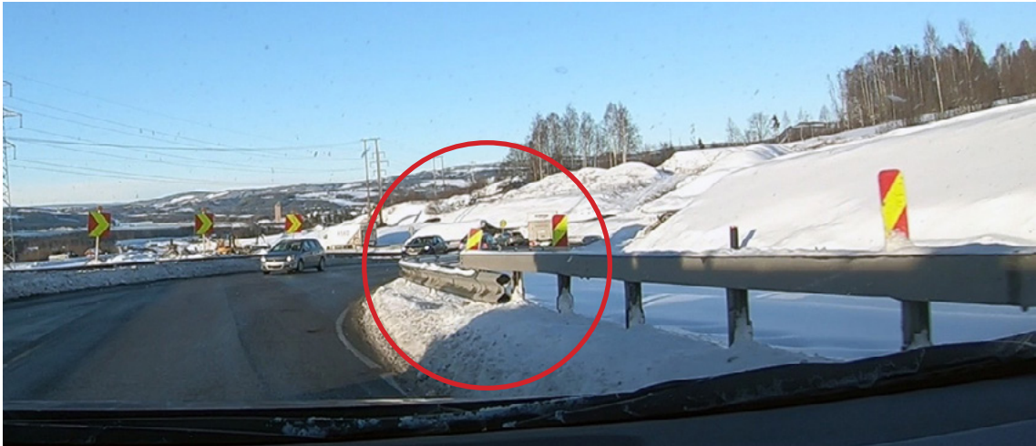
Bilde 3: Ikke godkjent rekkverkovergang mellom eksisterende og midlertidig rekkverk, mot fartsretningen, i nedoverbakke
