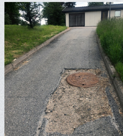
Hol i vegbana. Ikkje i samsvar med krav til vegdekke/fast dekke.
