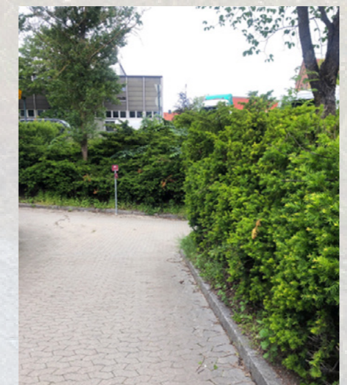
Vegetasjon som hindrar sikt i kryss. Ikkje i samsvar med krav til sikt.
