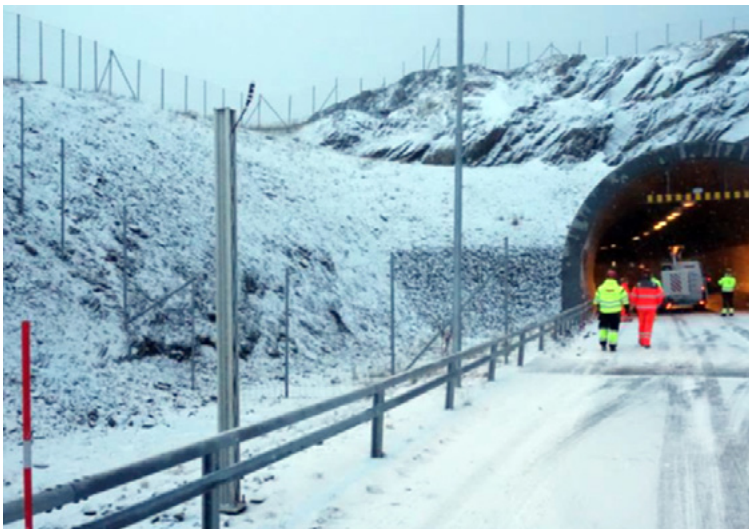
Bilde 5: En rød-blink på Hammerfest-siden mangler. Det opplyses at denne har manglet i snart et år. Avdelingen ser ikke at dette er en sikkerhetsfunksjon som må utbedres. Diskusjonen går på om dette er brøyteskade og hvem som har ansvar.
