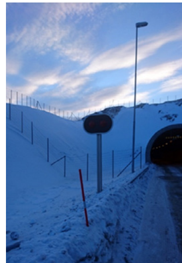
Bilde 6: Dokumentert tilstand 27.02.2019
