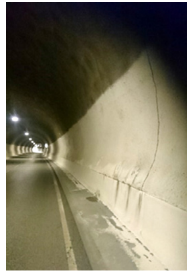
Bilde 4: Dokumentert tilstand 27.02.2019
